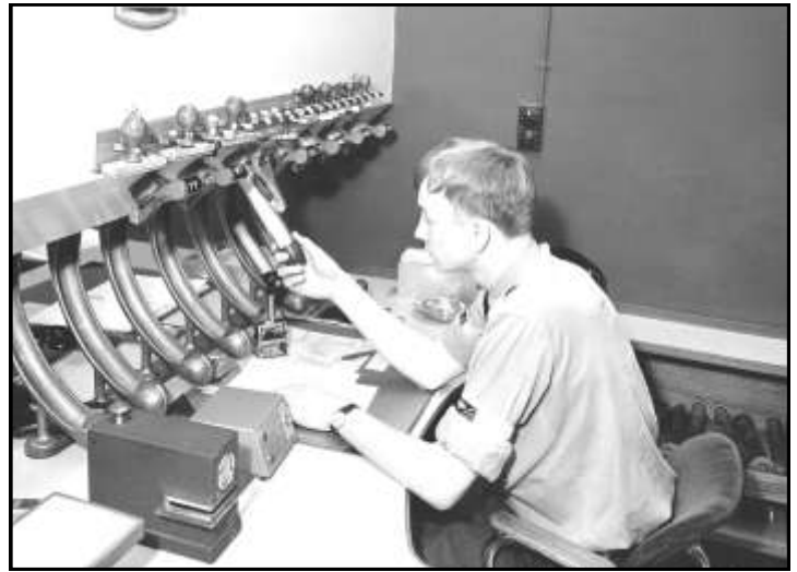
Endnu i 1962 var røpost et vigtigt led i kommunikationen i FTK. På billedet betjenes systemet af en operatør på Signalkontoret.
